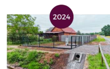
POZIOM SKANALIZOWANIA W roku 2024 poziom skanalizowania gminy wyniesie 100% (obecnie trwa budowa kanalizacji w Sołectwie Jeżowe-Zaborczyny)
