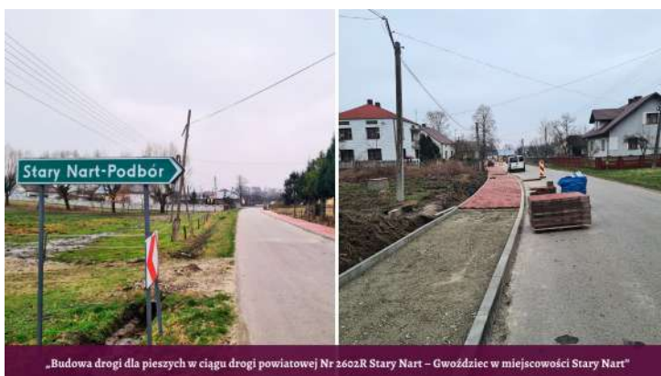
„Budowa drogi dla pieszych w ciągu drogi powiatowej Nr 2602R Stary Nart – Gwoździec w miejscowości Stary Nart”
